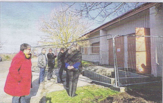
Les travaux de la nouvelle chaufferie ont commencé. Photo Michelle Gautraud (CLP)
